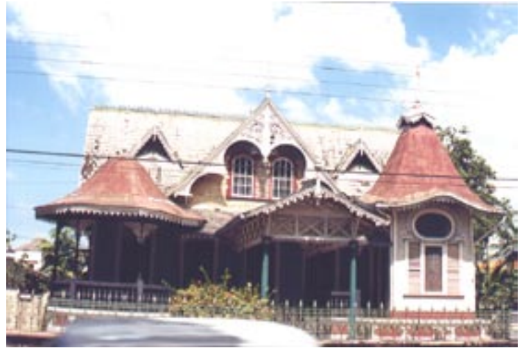
Port of Spain, Trinidad y Tobago. la soltura con que se aplican los conceptos arquitectónicos tropicales en este ejemplo, son difícilmente repetibles, ya que se perdería la "ingenuidad" del modelo.
