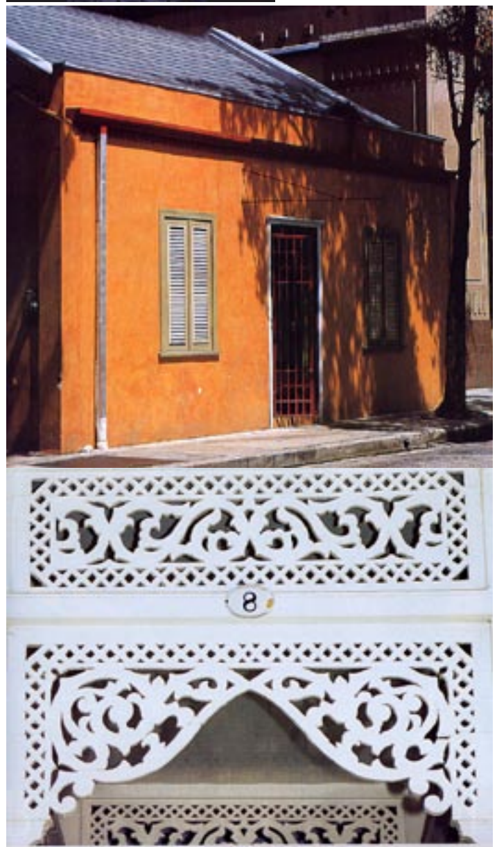
La creatividad caracteriza a la arquitectura popular caribeña, la cual resuelve con total soltura los techos y aplica con profusión y maestría el "fretwork" o calado en madera. Fotografía, arq. Jimena Ugarte.
