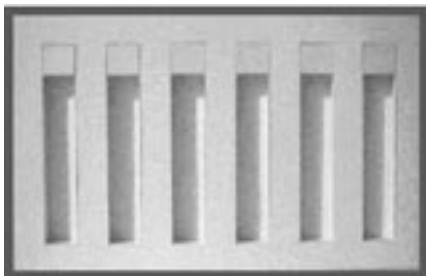
Fig. 3. Vista exterior de las ventanas
