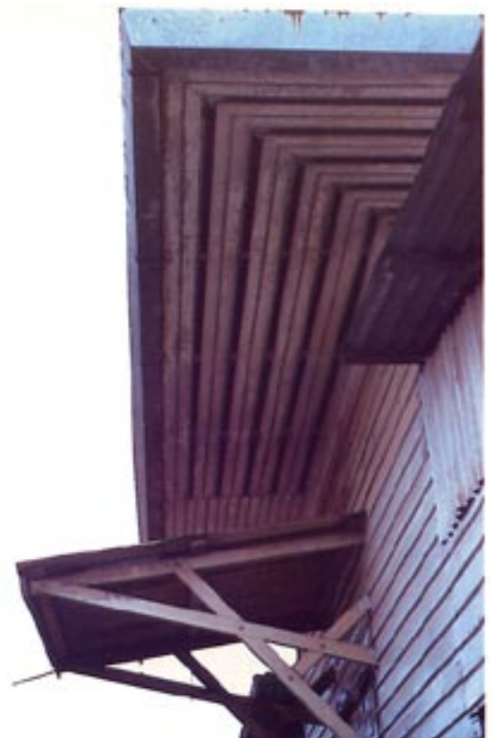
Corredor perimetral y aleros ventilados
