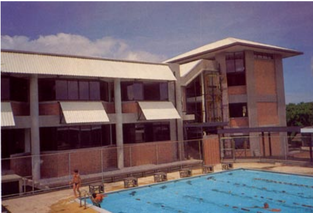
INSTITUTO PEDAGOGICO DE LOS COLEGIOS ALEMANES DE CENTROAMERICA, 1991-1993 La fachada desmaterializada, tan propia de las arquitecturas tropicales populares se expresa en su versión moderna en este edificio. El vocabulario formal destaca los aleros, la estructura, la pared, la ventana, y los materiales texturados.
